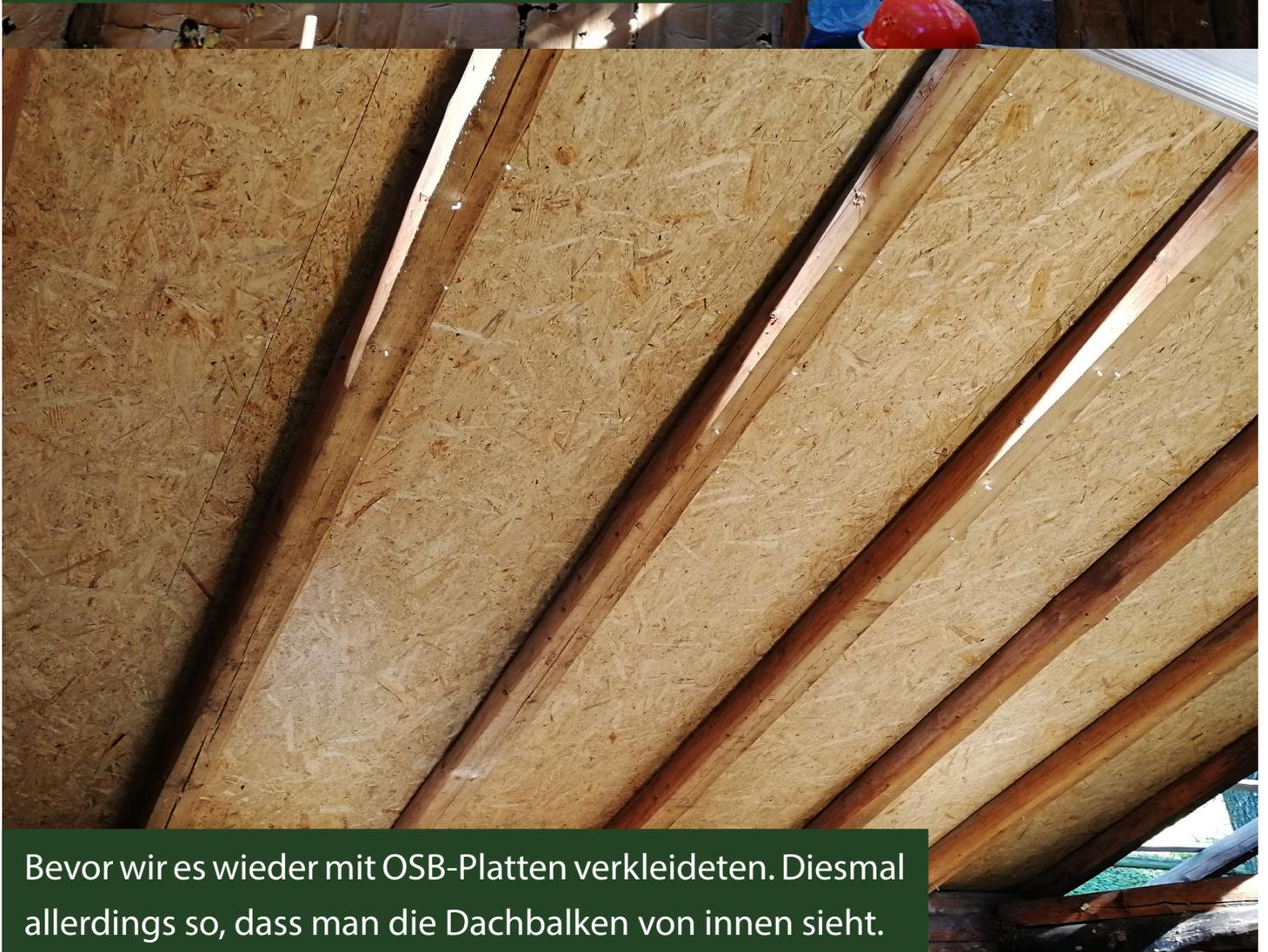
Bevor wir es wieder mit OSB-Platten verkleideten. Diesmal allerdings so, dass man die Dachbalken von innen sieht.
